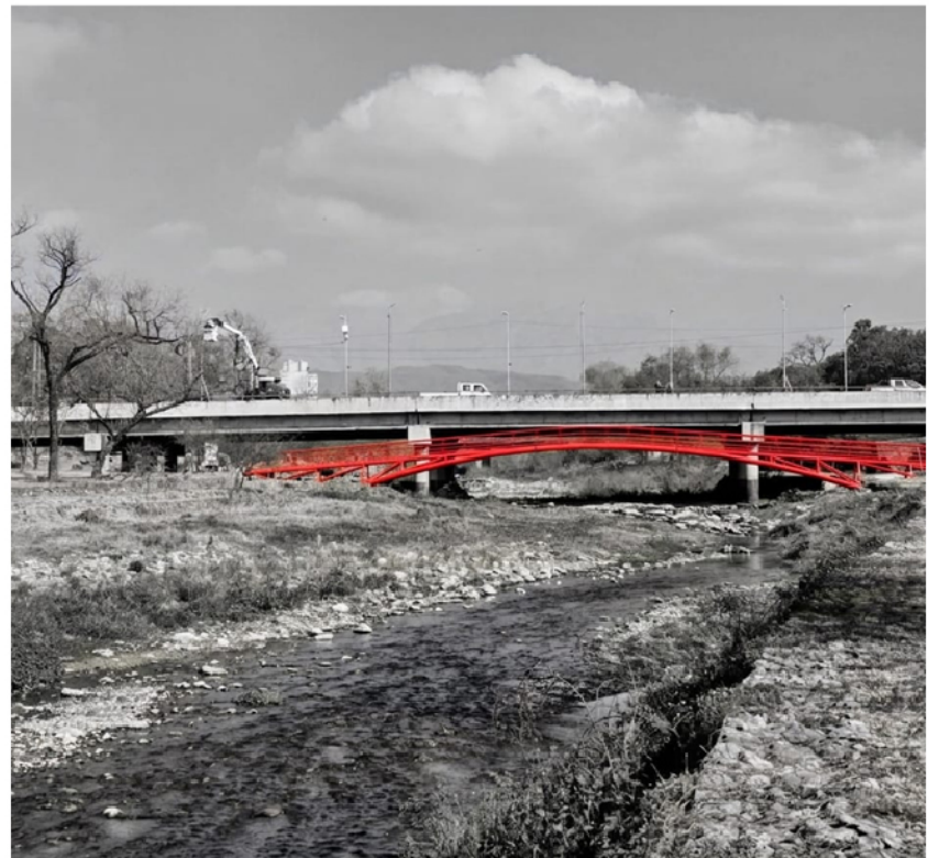
Imagen actual de la pasarela
