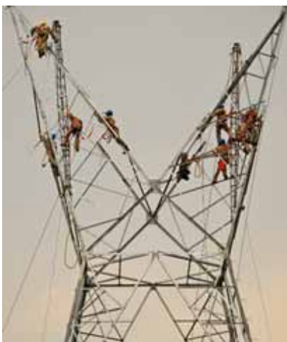
Armado de Torres LAT
